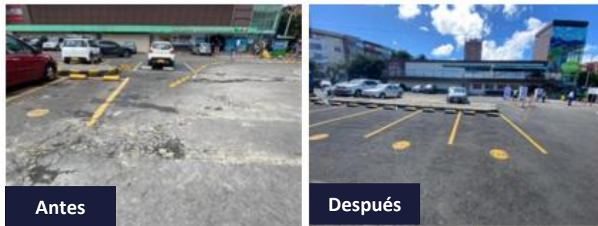
Ilustración 46. Renovación de estructura asfáltica en parqueadero Alhambra (localidad Suba)
