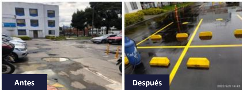
Ilustración 47. Renovación de estructura asfáltica en parqueadero San Andresito (Localidad Punte Aranda)
