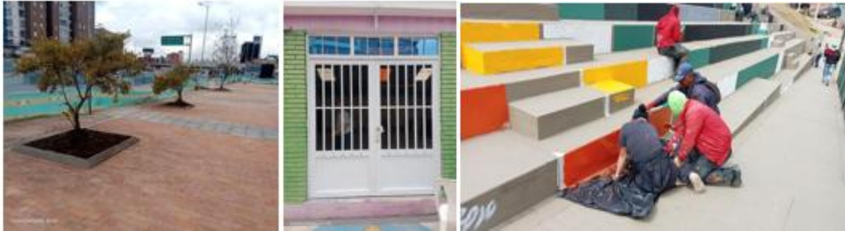
Ilustración 45. Obras de reinversión en el espacio público en las localidades de Teusaquillo y Usme
